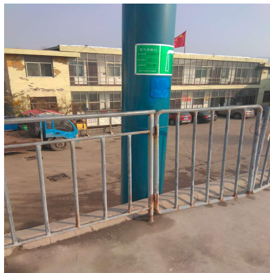
图 10 模具切割工序排气筒
