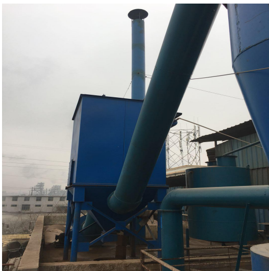
图 4 脉冲布袋除尘器
