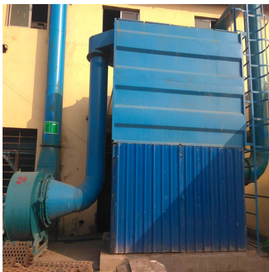
图 2 脉冲布袋除尘器
